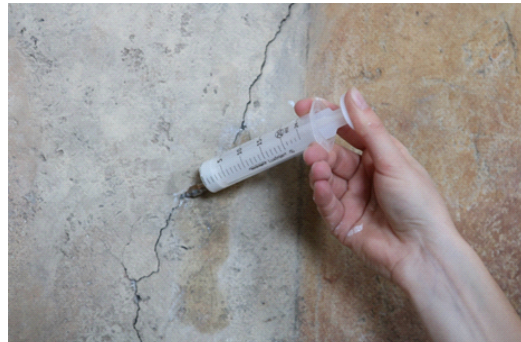
Ukázka injektování středové trhliny
