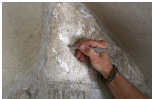
Odstraňování nevhodných tmelů a zbytků vrstev nad nápisovou tabulkou.
